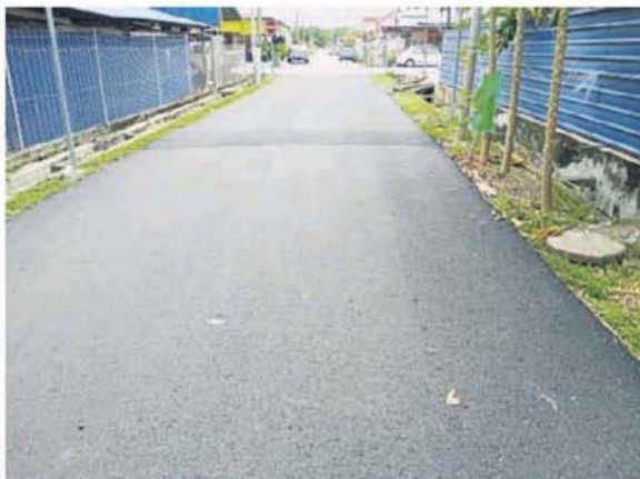
路重铺工程。瓜拉冷岳市议会为仁嘉隆新村进行道
