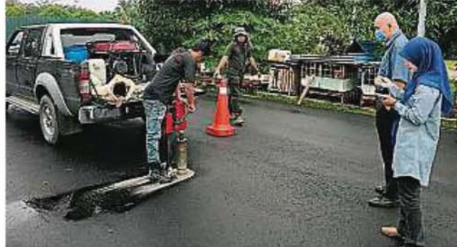
瓜冷市议会工程局和铺路承包商在仁嘉隆道路，进行厚度测试。右二为刘永山
