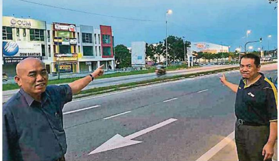
刘永山 (左) 巡视街灯维修工程的完工情况。右为瓜冷新村协调官林立选。
